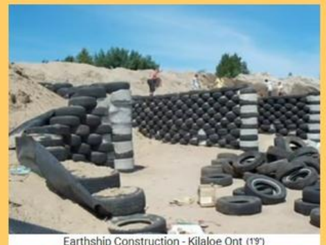
Earthship Construction - Killaloe Ont (197) Killaloe, construcción de nave tierra 03: paredes de llantas de tierra son estabilizadas con cemento, área lateral
