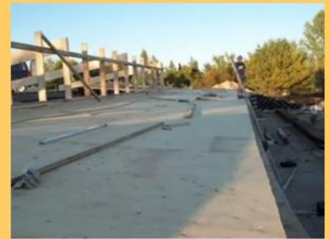
Earthship Construction - Killaloe Ont (3157) Killaloe, construcción de nave tierra 12: trabajos en el techo 02
