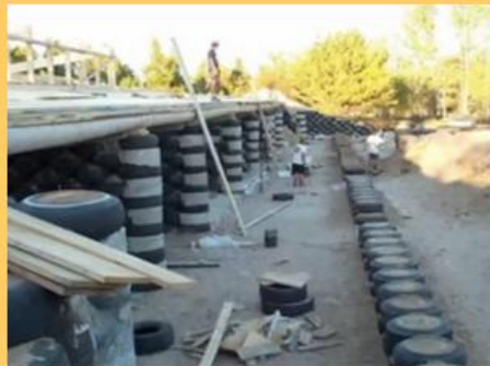
Earthship Construction - Killaloe Ont (3247) Killaloe, construcción de nave tierra 13: trabajos en el techo 03 y trabajos en el frente 04
