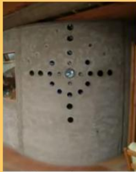
Earthship Construction - Kilaloe Ont (997)
