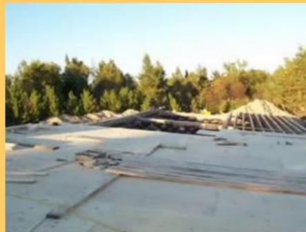
Earthship Construction - Killaloe Ont (367) Killaloe, construcción de nave tierra 11: trabajos en el techo 01
