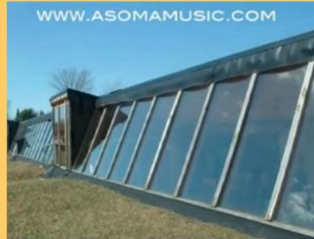
Earthship Construction - Kilaloe Ont (119)
