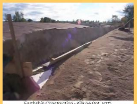
Earthship Construction - Killaloe Ont (4377) Killaloe, construcción de nave tierra 18: el muro principal de atrás y la construcción del techo son revocados 02
