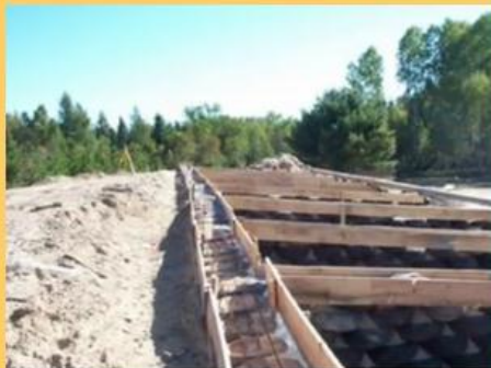
Earthship Construction - Killaloe Ont (2597) Killaloe, construcción de nave tierra 10: trabajos de encofrado en la zona del tejado 04
