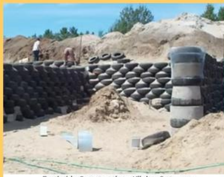
Earthship Construction - Killaloe Ont (487) Killaloe, construcción de nave tierra 02: paredes de llantas de tierra son estabilizadas con cemento
