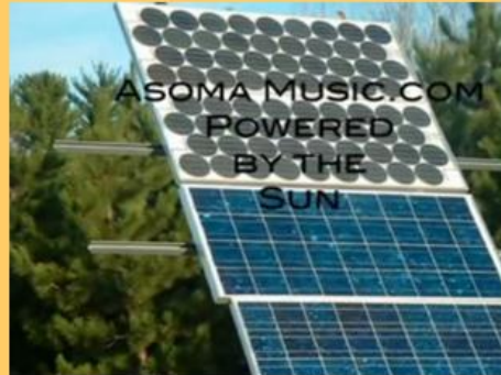
Earthship Construction - Kilaloe Ont (926)
