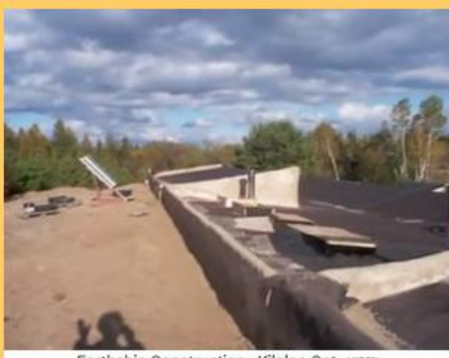
Earthship Construction - Killaloe Ont (4287) Killaloe, construcción de nave tierra 17: el muro principal de atrás y la construcción del techo son revocados 01
