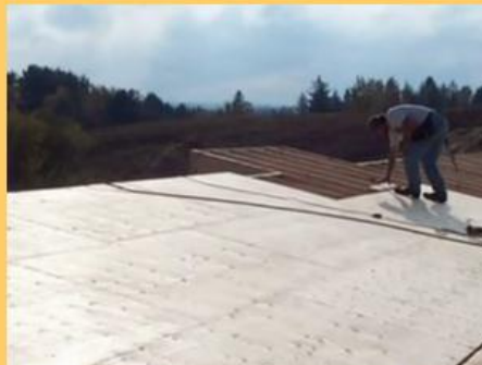
Earthship Construction - Killaloe Ont (3357) Killaloe, construcción de nave tierra 14: trabajos en el techo 04
