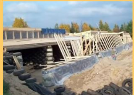
Earthship Construction - Killaloe Ont (3397) Killaloe, construcción de nave tierra 15: trabajos en el frente 02
