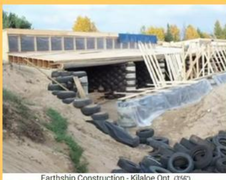
Earthship Construction - Killaloe Ont (3567) Killaloe, construcción de nave tierra 16: construcción del techo y del frente 03
