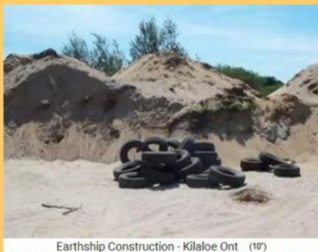
Earthship Construction - Killaloe Ont (107) Killaloe, construcción de nave tierra 01: llantas+un montón de tierra / arena
